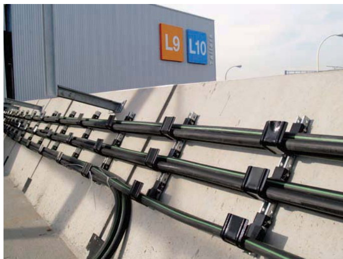
Ejemplo de instalación para diferentes tipos de cable. Installation example for different types of cable.
